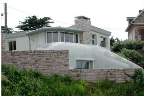
Vue générale du blockhaus de La Heussaye
